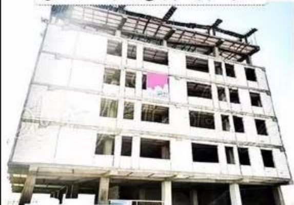
عایق کاری حرارتی با بلوک هبلکس
