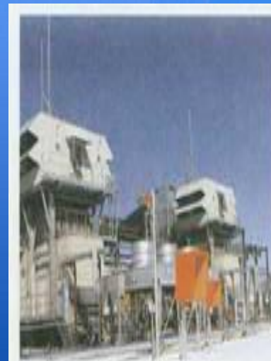
شکل ۱۲. ایستگاه تقویت فشار ۱۷۰ کلو
