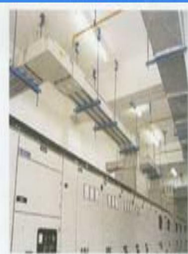
شکل ۱۱. باسداکت شمال ایستگاه تقویت فشار ۱۱۰ کلو
